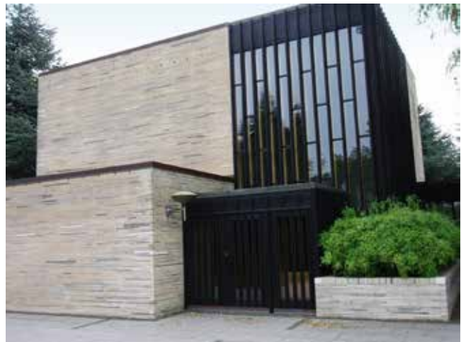
Krematoriet i Roskilde er et af de krematorier der skal lukke, når det nye fælleskrematorium kan overtage kremationerne i 2012.
